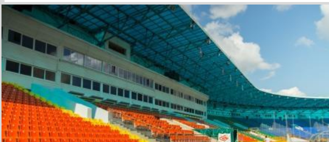
Кровля футбольного стадиона, г. Казань
