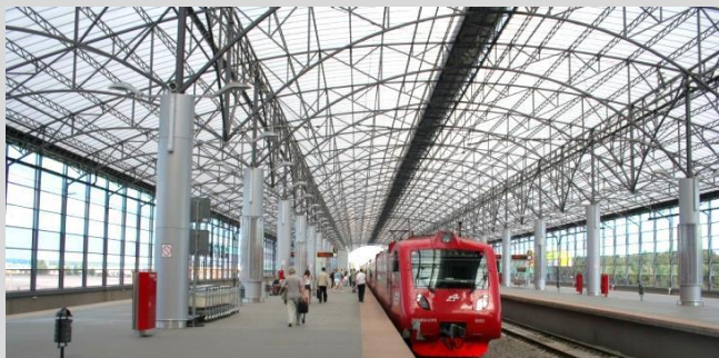
Кровля вокзала аэроэкспресса Шереметьево
